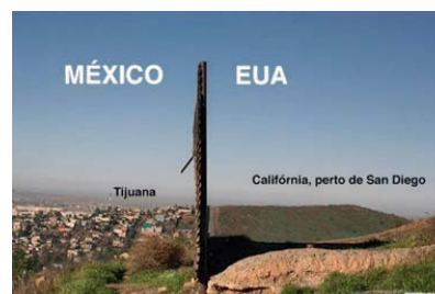
Construção do muro que separa EUA e México
