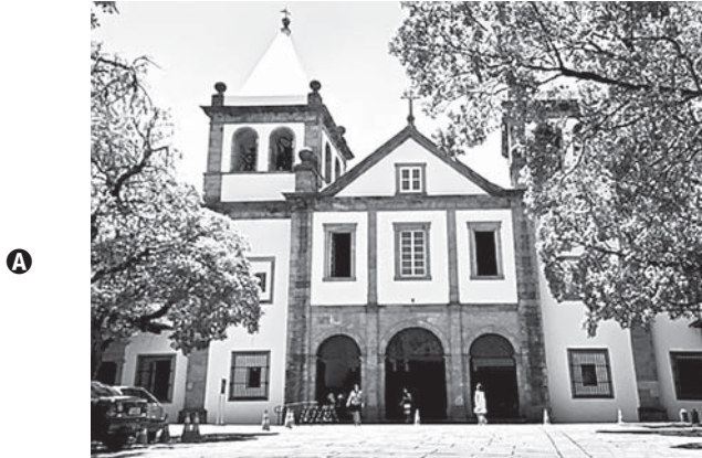
Mosteiro de São Bento (RJ)
